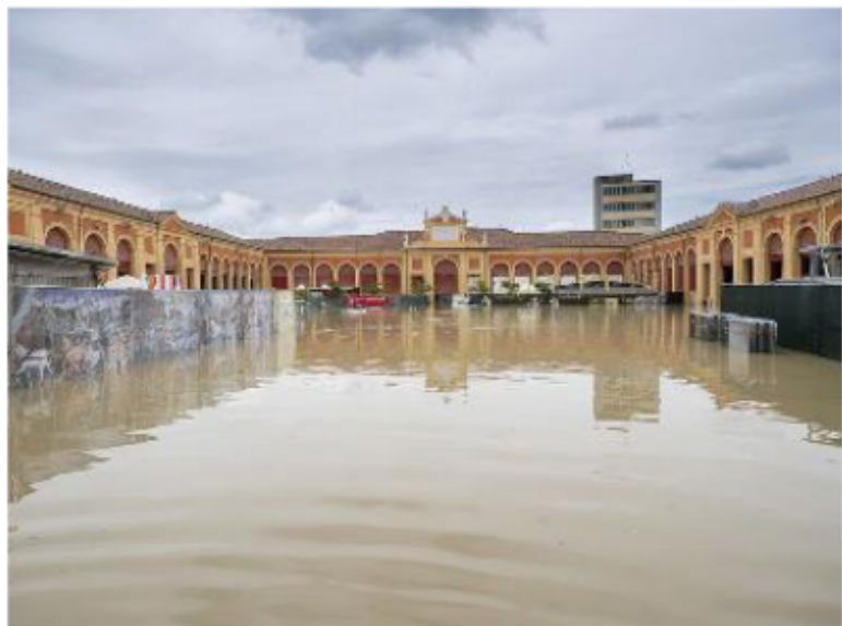
Pavaglione, monumento e Baracca e Rocca di Lugo completamente allagati (Zani)
